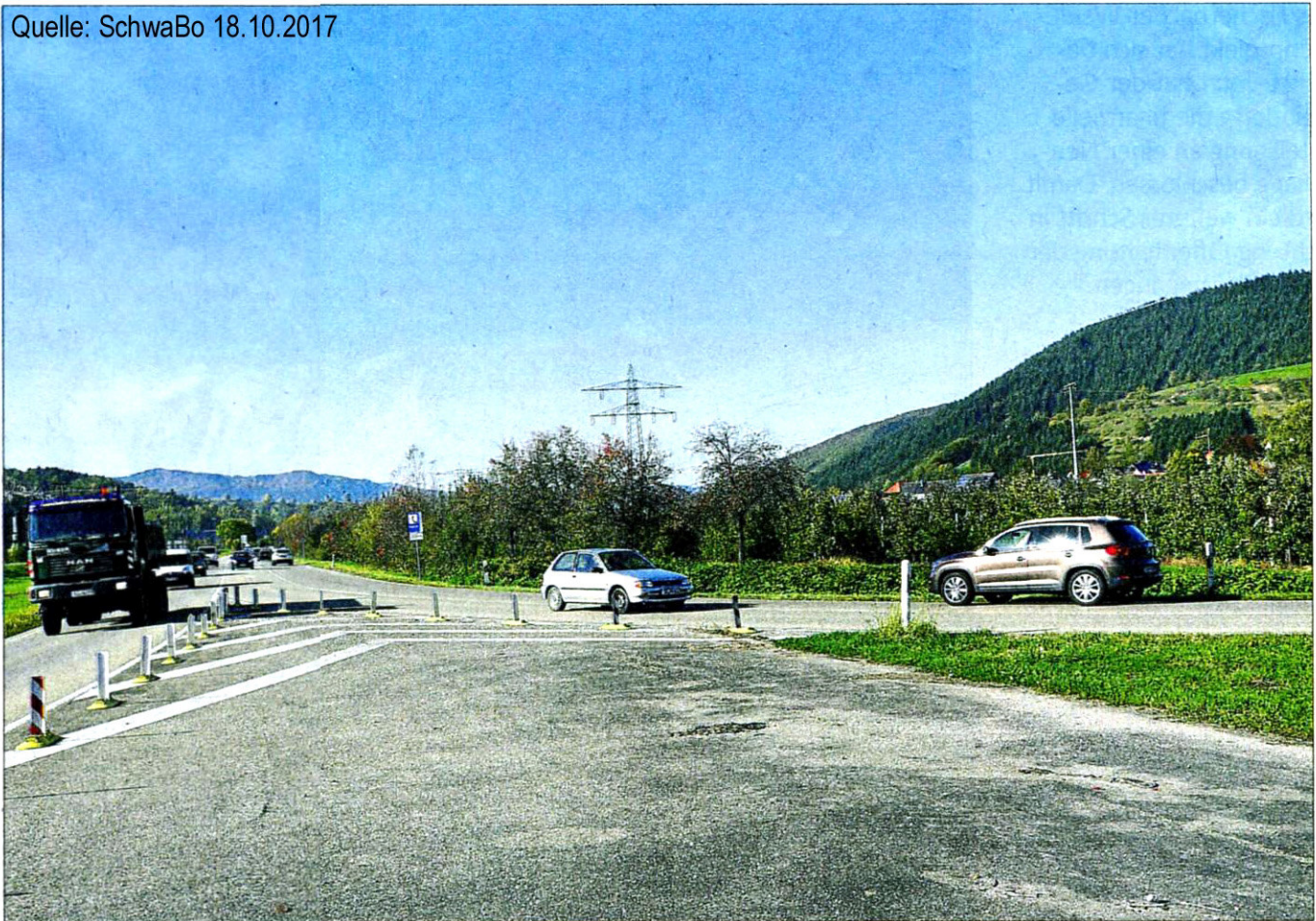
Auch der Knotenpunkt Haslach West soll nach dem Wunsch der Bollenbacher in die Planung aufgenommen werden. Foto: Kornfeld
